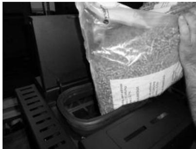
Figura 26 – Reabastecimento do depósito de pellets
